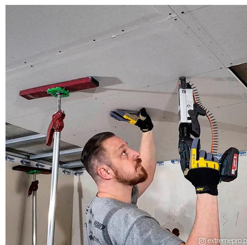
L'Arm+ garantit que votre support télescopique Multiprop peut être utilisé d'une seule main. Il est monté à la place de la tête standard.
